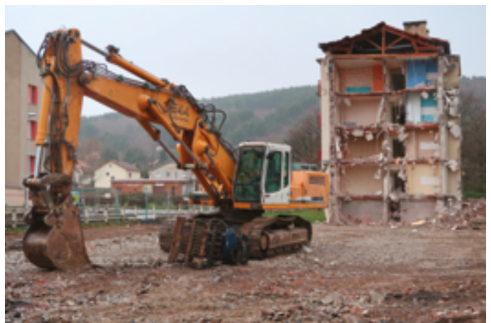
23.03.17 : déconstruction du bâtiment «Aubépine», quartier du Val Fleuri à Langeac.
