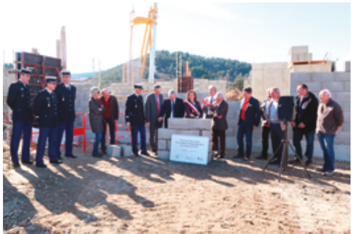
10.03.17 : pose de 1ère pierre de la caserne de gendarmerie de Vorey.
